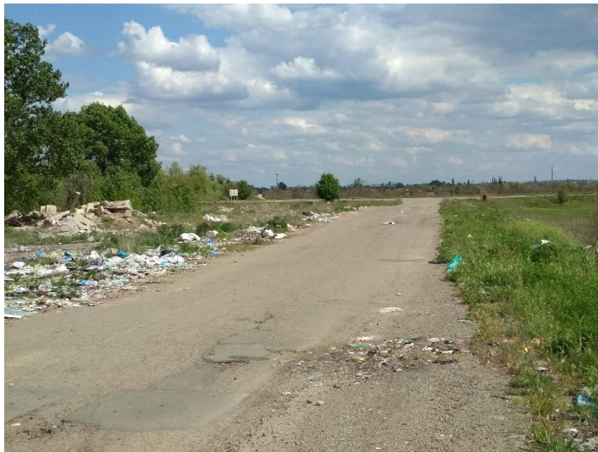
Рис. 4.5 – Вигляд другорядної дороги, яка прилягає до траси Е-105 «Дніпро-Харків» біля міста Новомосковськ
