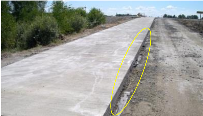
Рис. 4.6 – Нові бетонні автобани мають поліетиленову гідроізоляцію (обведена ділянка), що підвищує довговічність автошляхів
