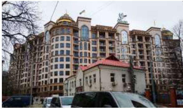
Рис. 1. 10-ти поверховий будинок по вул. Кіквідзе м. Київ з системою сейсмовіброзахисту
