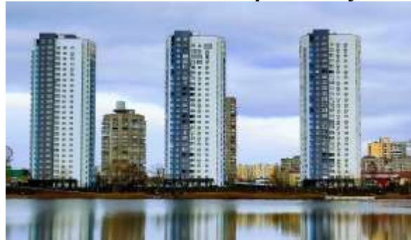
Рис. 2. Три 27-ти поверхових будинки по Оболонському проспекту м. Київ з системою сейсмовіброзахисту
