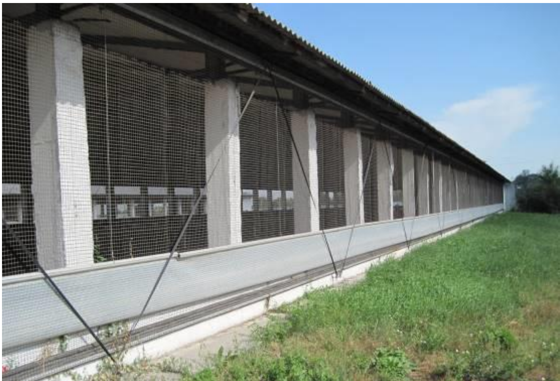
Рис. 2. Корівник на 400 корів з піднятими мобільними шторами
