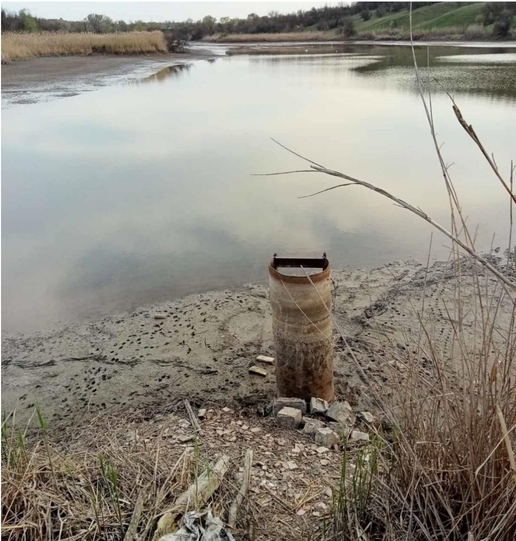
Рисунок 4.5 – Водовідвідна труба водоскиду ставка №13
