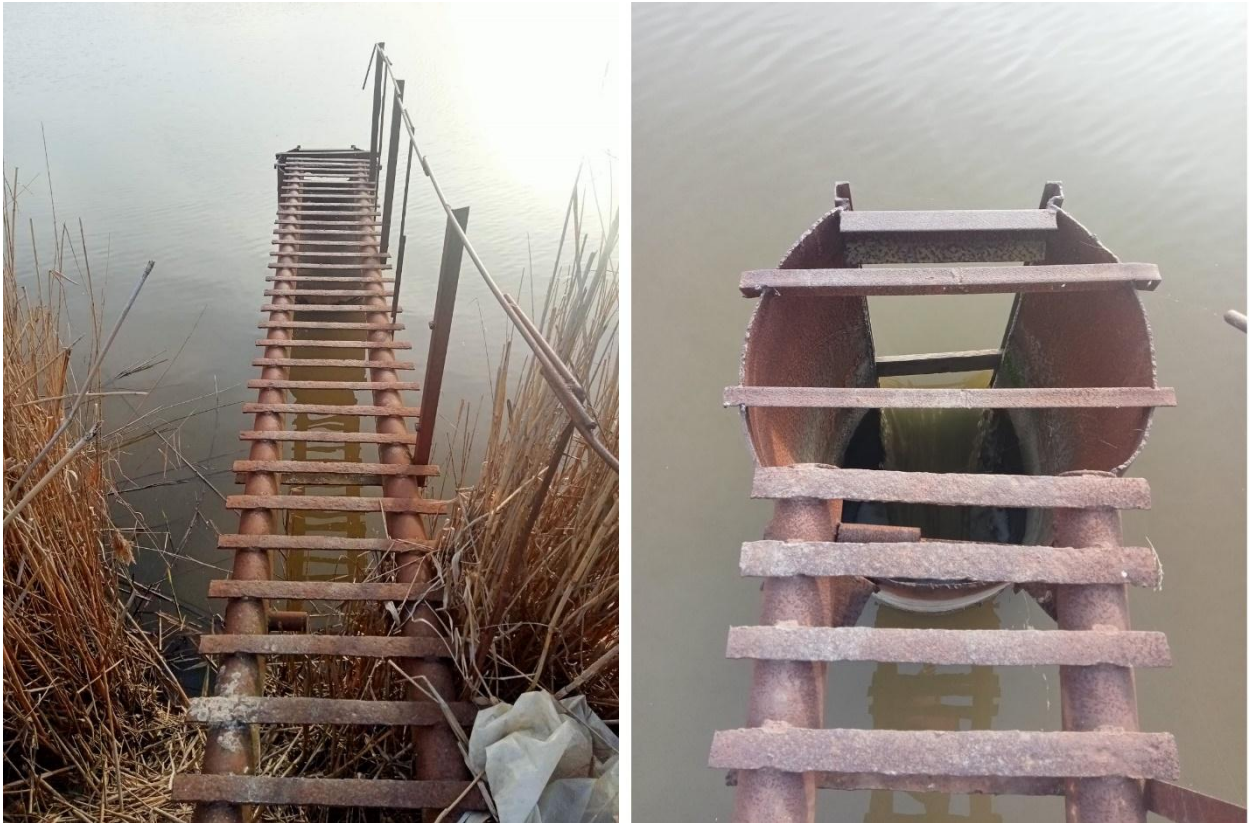
Рисунок 4.4 – Водовідвідна труба водоскиду ставка №11
