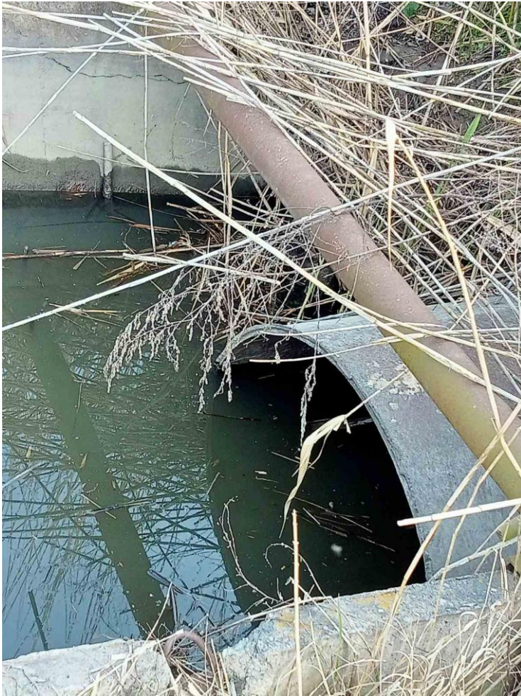
Рисунок 4.2 – Водовідвідна труба водоскиду ставка №4
