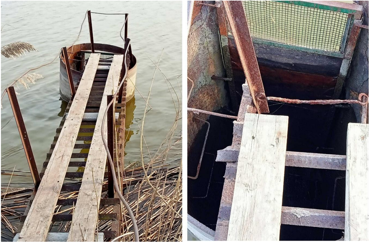
Рисунок 4.3 – Водовідвідна труба водоскиду ставка №12
