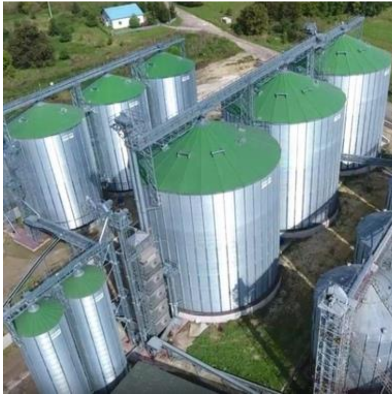
Рис. 2.2 Вигляд конструкції силосних корпусів з покращеним покриттям
