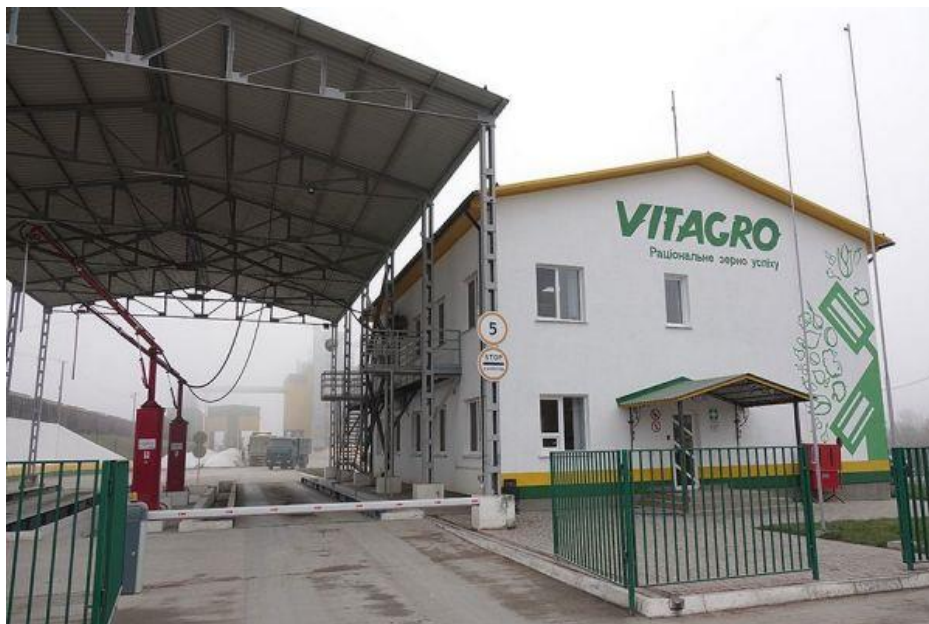
Рис. 2.3 Приклад захисного покриття в пункті відбору проб з автотранспорту
