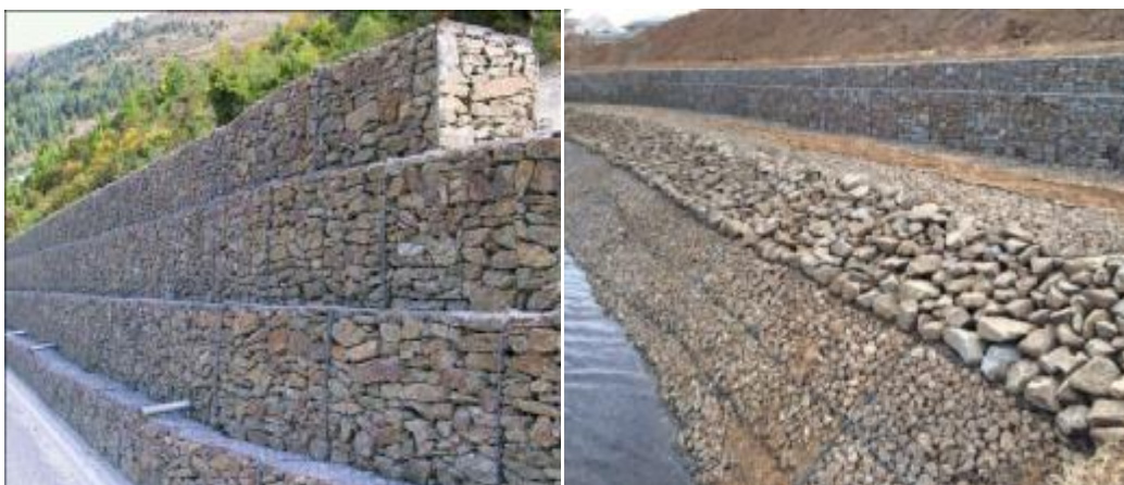
Рис. 2 Влаштування габіону
