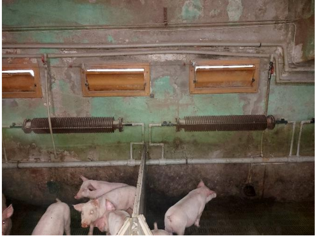
Рис. 5. Бокові вентиляційні клапани і дельти для обігріву.
