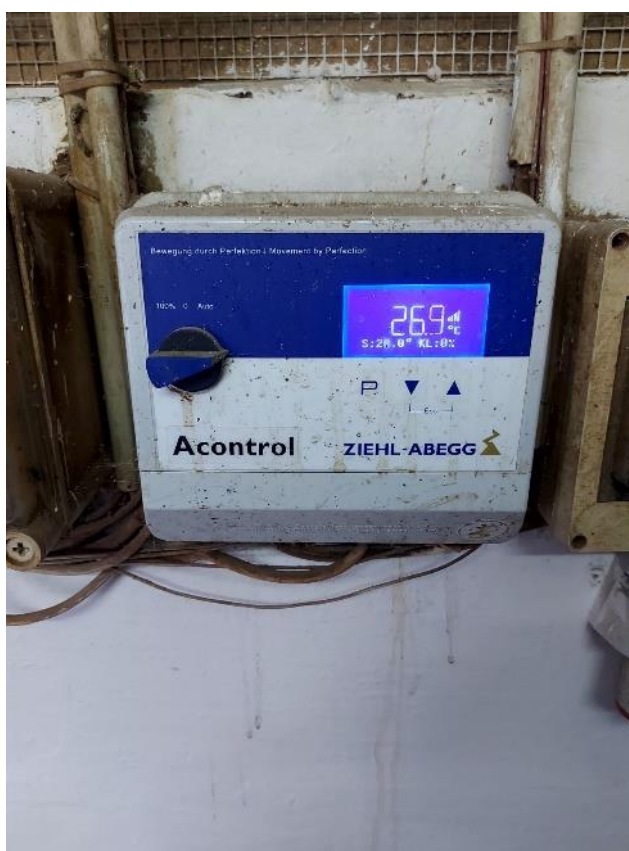
Рис. 4. Контролер параметрів мікроклімату (комп'ютер Acontrol компанії Ziehl-Abegg).
