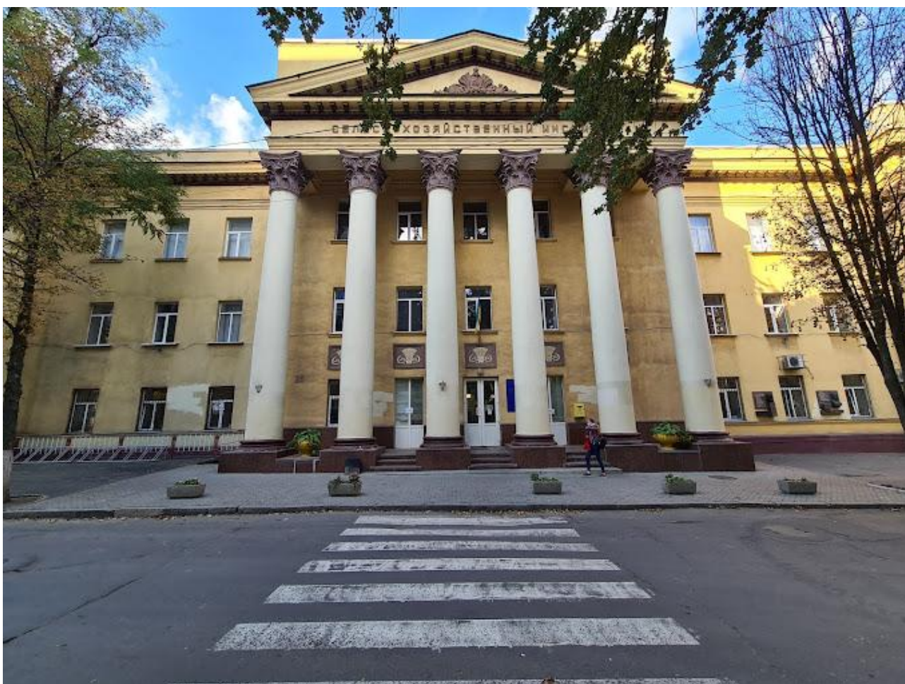
Рис. 2.2. Навчальний корпус №1 ДДАЕУ (старий корпус)
