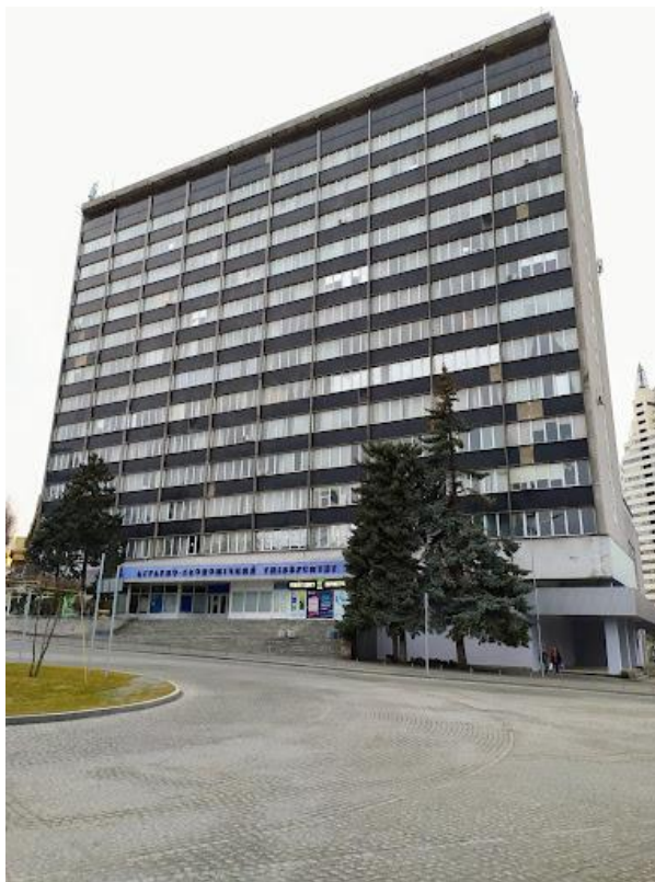
Рис. 2.1 Навчальний корпус №2 ДДАЕУ (новий корпус)
