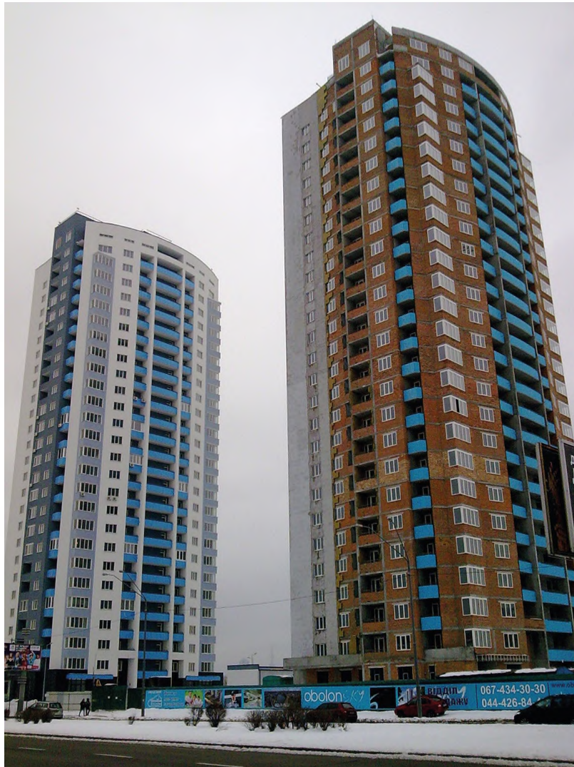
Рисунок 6 – Общий вид 27-этажных жилых домов по Оболонскому проспекту в г. Киеве с системой виброизоляции (расположением на расстоянии 100 м от линии метрополитена мелкого заложения)
