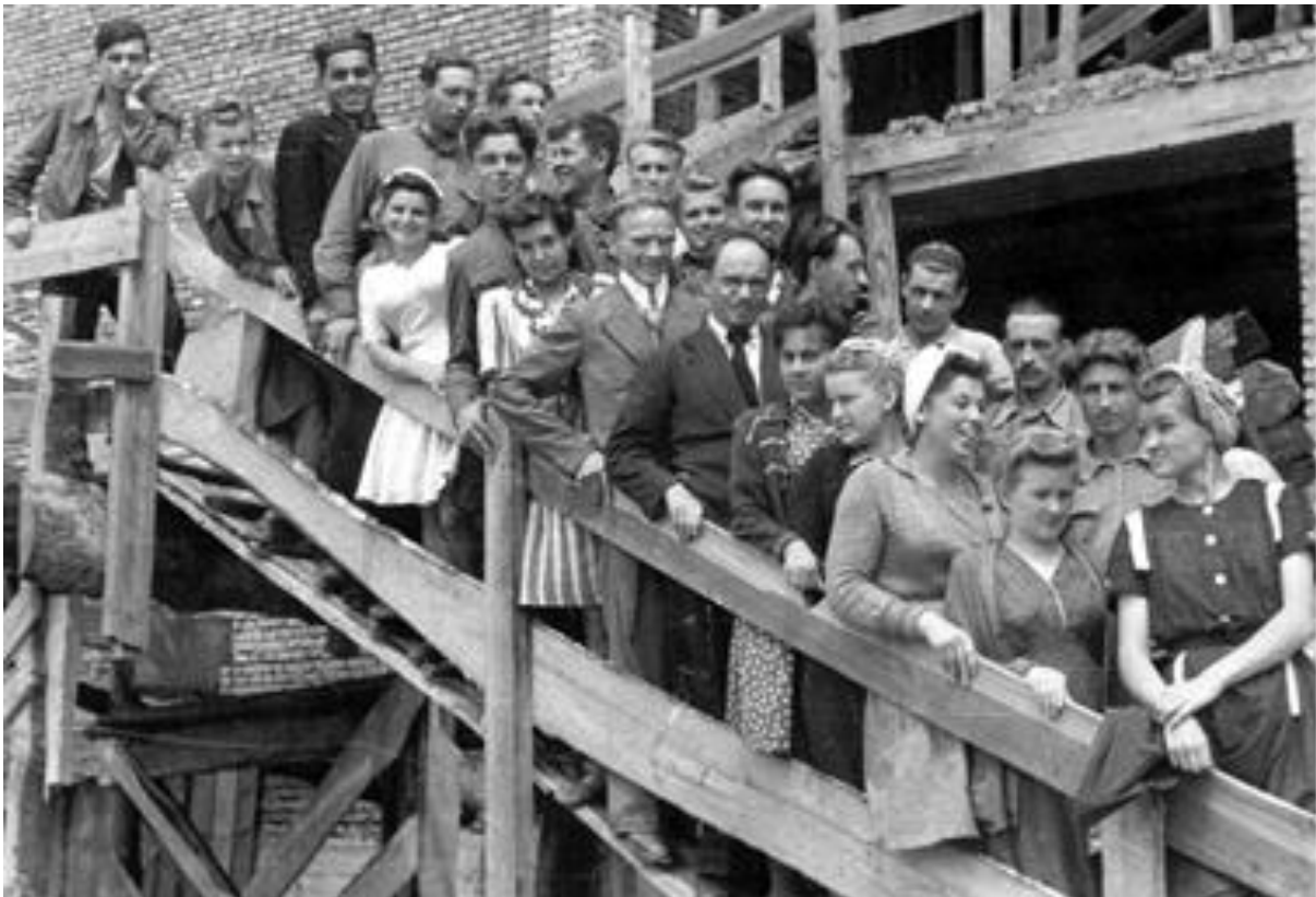
Група студентів-будівельників на відновлювальних роботах V корпусу.
