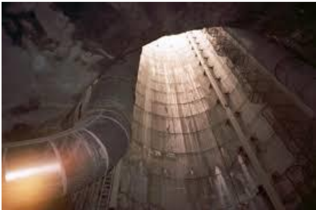
Рисунок 6.1 – Система промислової вентиляції на шахтах.
