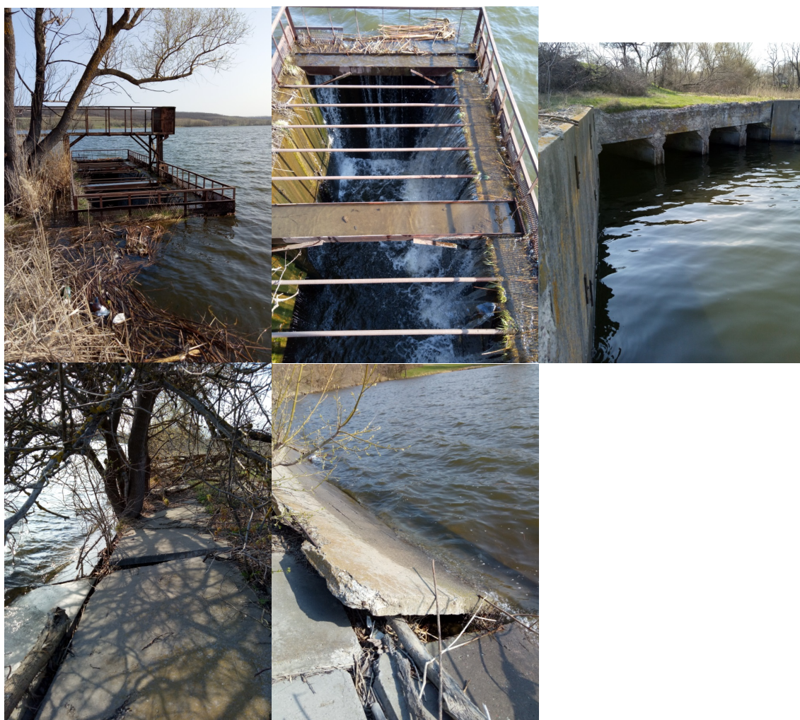
Рисунок 2.5 – Сучасний стан гідровузла та водоскиду на р. Домоткань в с. Якимівка
