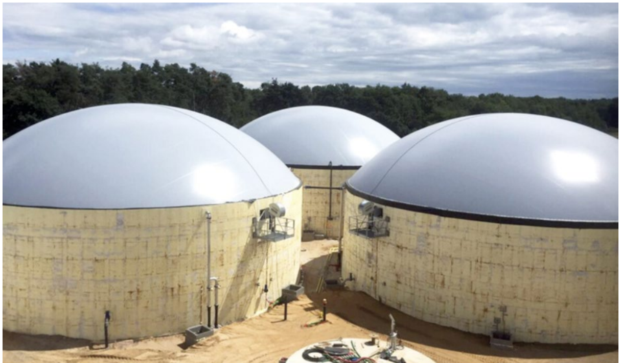
Рис. 6 – Метантенки з мембранними газгольдерами
