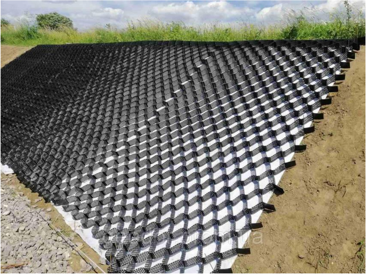
Рисунок 2.3 – Приклад улаштування георешітки на укосах дамби
