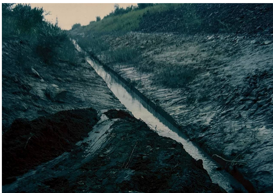
Рисунок 4.20. – Стік води після аварійного переливу з хвостосховища Войково. Помітно рівень наповнення каналу під час максимального скиду. Місце відбору проби № 38. [22]
