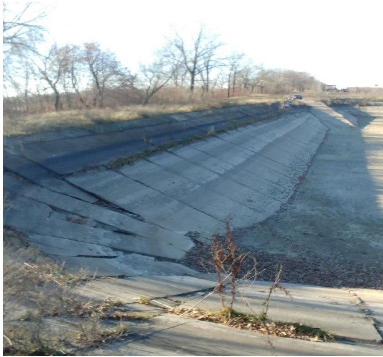
Рисунок 2.6 – Порушення гідроізоляції на ділянці зчленування східного та північного бортів дамби РБ-1 Кільченської зрошувальної системи
