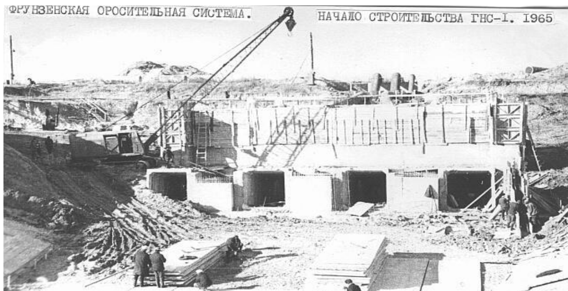
Рисунок 2.2 - Початок будівництва Фрунзенської зрошувальної системи (1965 р.)
