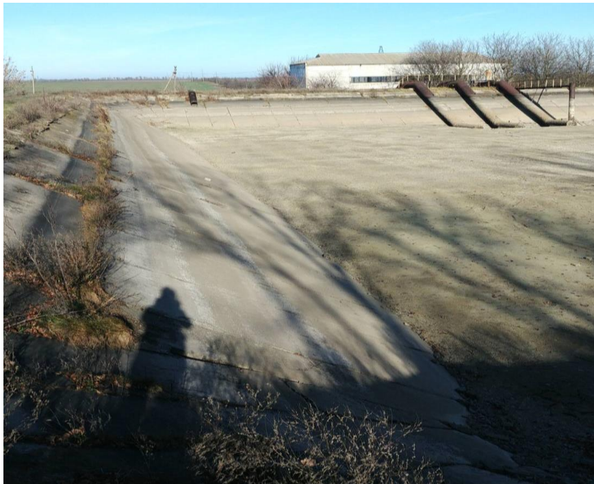
Рисунок 2.6 – Порушення гідроізоляції на ділянці зчленування східного та північного бортів дамби РБ-1 Кільченської зрошувальної системи
