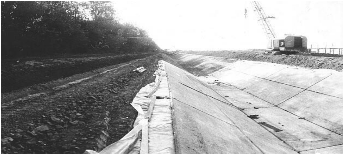
Рисунок 2.1 - Облицювання магістрального каналу залізобетонними плитами на водонепроникній плівці (1965 р.)
