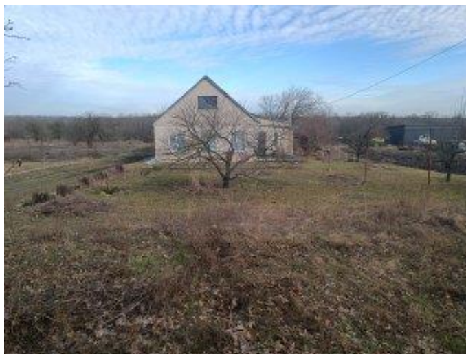
Рис. 2.2. Вид на житловий будинок
