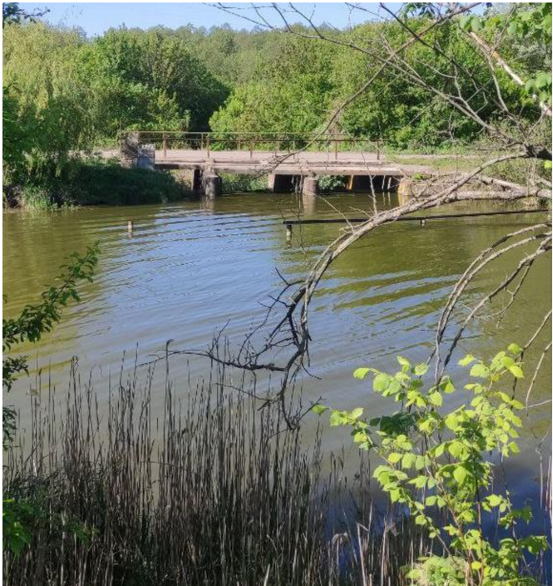
Рисунок 5.1 – Вид на дамбу з боку водосховища 04.05.2024 (фото автора)
