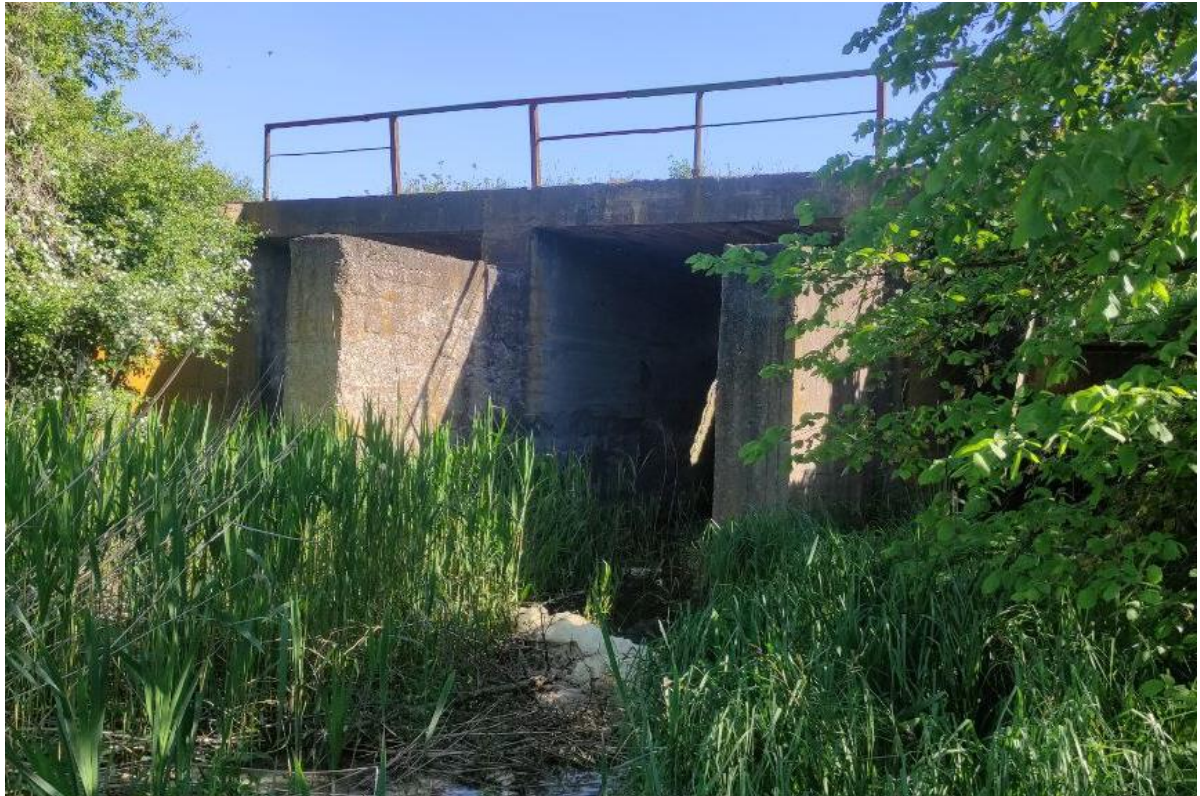
Рисунок 5.2 – Вид на водоскидну споруду з річки Золотоношка нижче за течією 04.05.2024 (фото автора)
