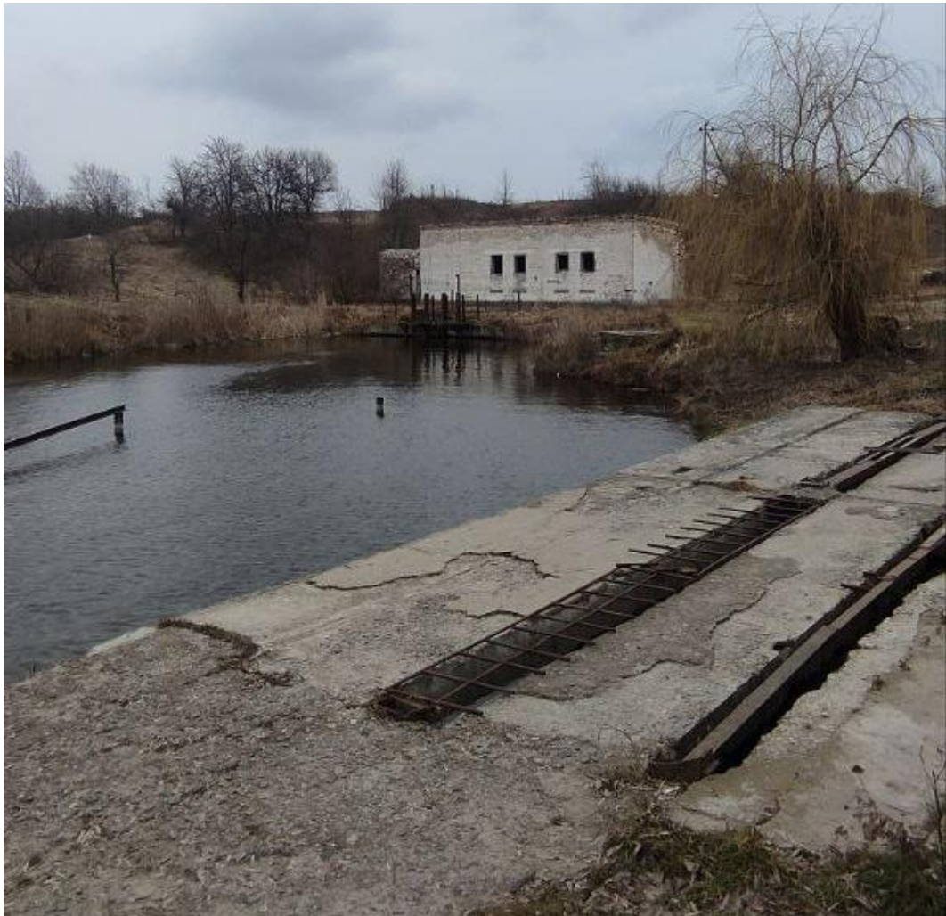
Рисунок 5.4 – Вид на приміщення колишньої насосної станції 03.03.2024 (фото автора)
