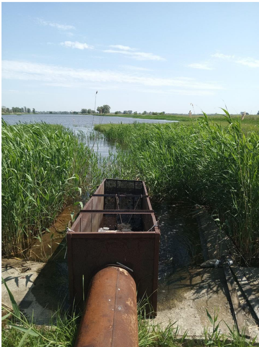
Рис. 2. Сміття- та рибоуловлювач у ПрАТ «Петриківський рибгосп»
