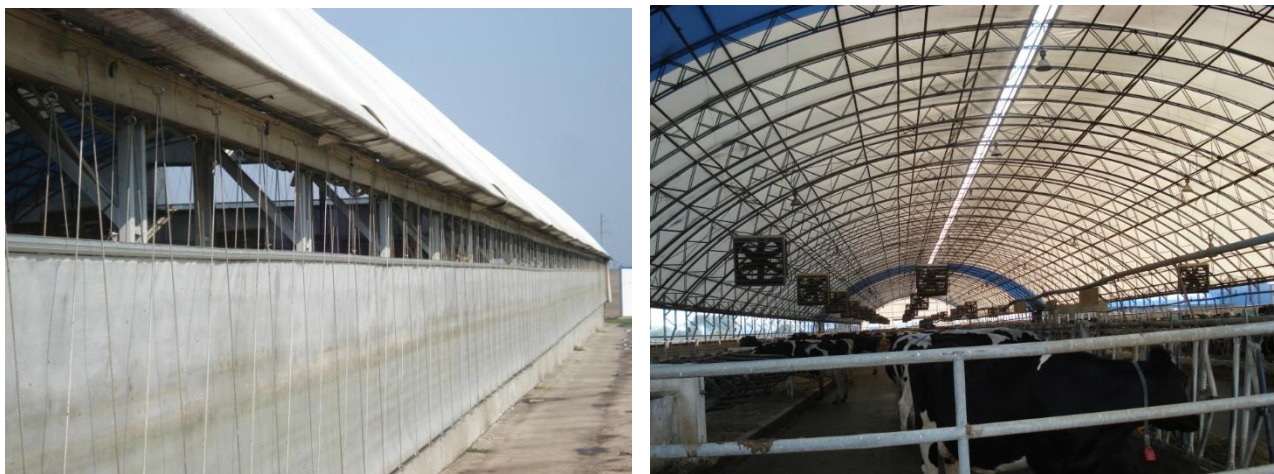
Рисунок 1.5 - Вентиляція приміщень ферми
