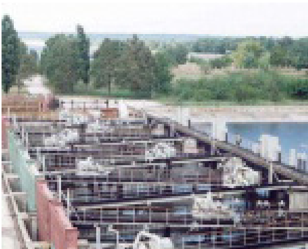
Рис. 2. Рибозахисний пристрій (РЗП) на каналі Дніпро-Донбас для запобігання потрапляння риби: а – загальний вигляд з траси каналу; Б – рибозахисний пристрій типу ламаної «плоскої сітки».
