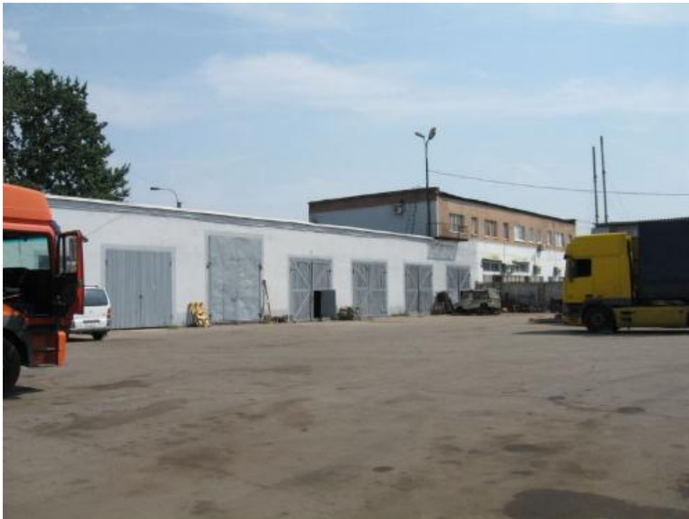
Рисунок 1.1 – Ремонтна база ПП «Флоід»: бокси та подвір'я
