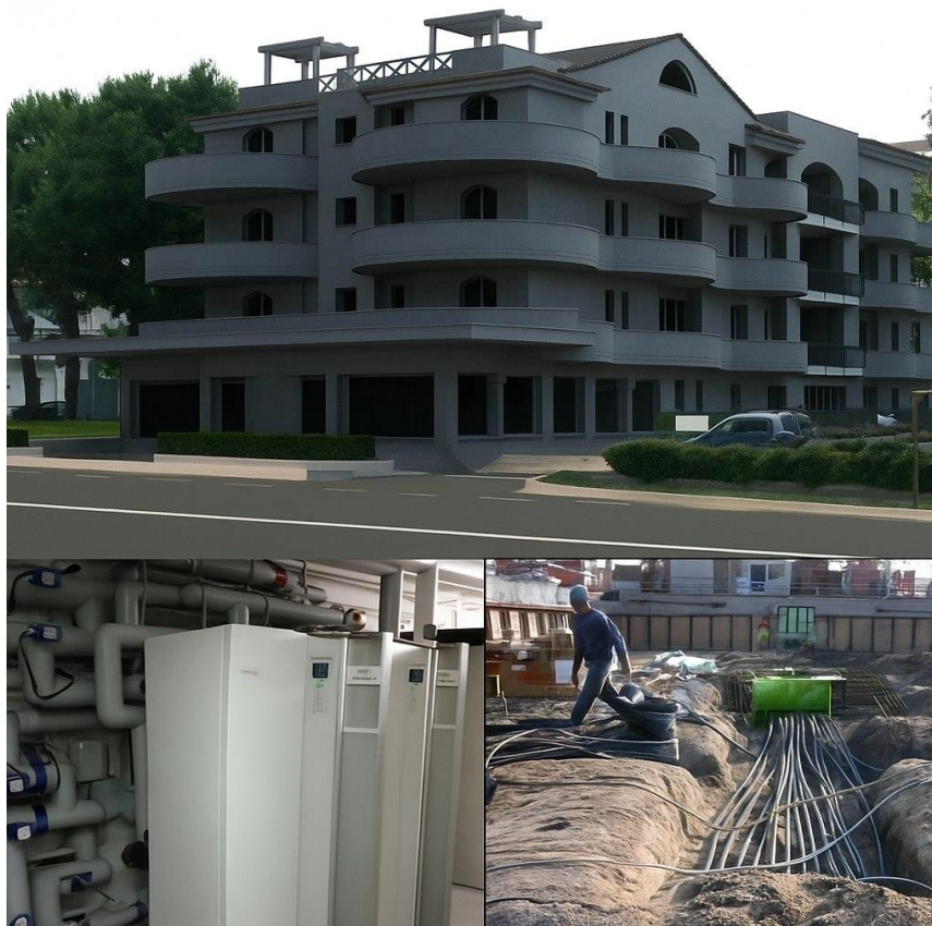
Рисунок 1.4 – Система центрального тепlopостачання житлового 25-квартирного будинку на основі теплового насосу м. Червія, провінція Равенна, Італія
