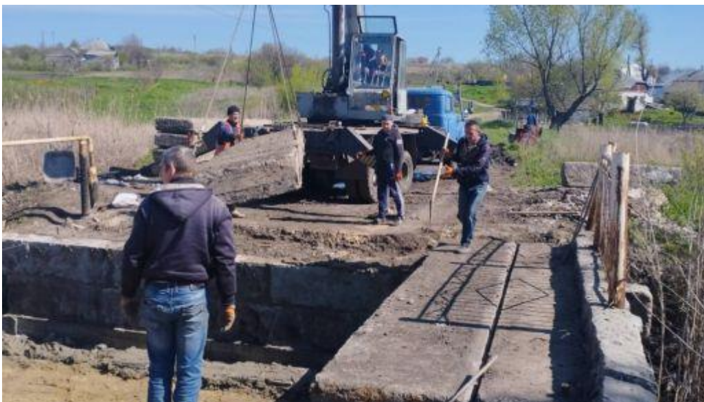
Рисунок 5.1 – Монтаж прольотної частини мосту: https://dumka.media/ukr/renovation/1686638615-na-harkivshchini-vidnovlyat-7-mostiv-zruynovanih-viynoju
