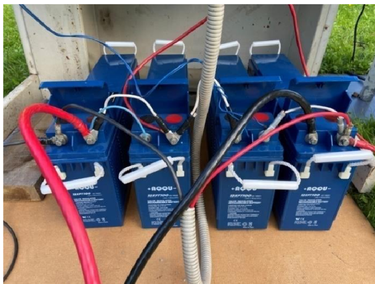
Рисунок 4 – Акумуляторні батареї, з'єднані послідовно-паралельно напругою 24 В
