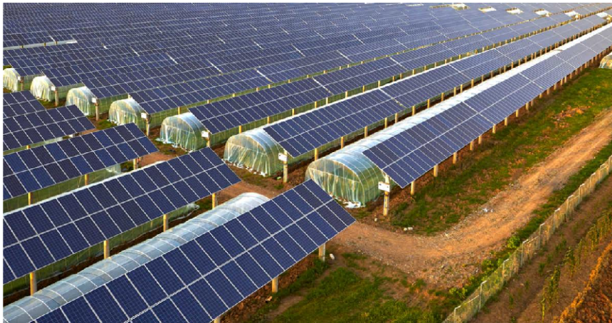
Рисунок 2 – Електропостачання культиваційних споруд
