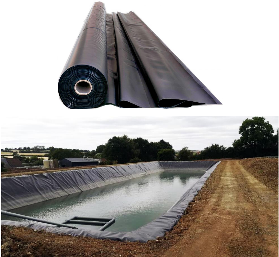
Рисунок. 2.8. Загальний вигляд геомембрани та приклад облаштування під час будівництва регулюючого басейну (фото з мережі Internet)
