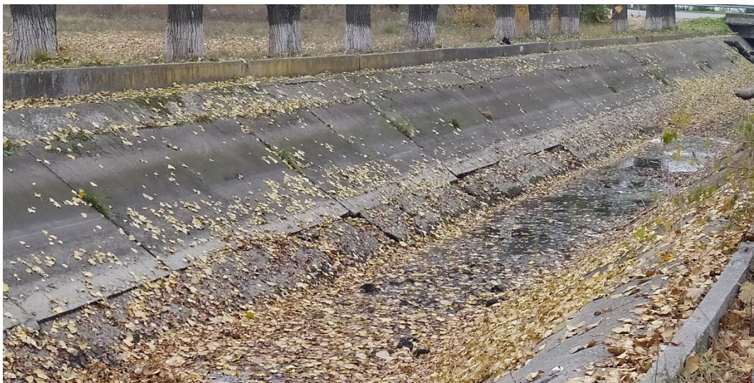
Рисунок 1 – Зовнішній вигляд залізобетонних конструкцій магістрального каналу
