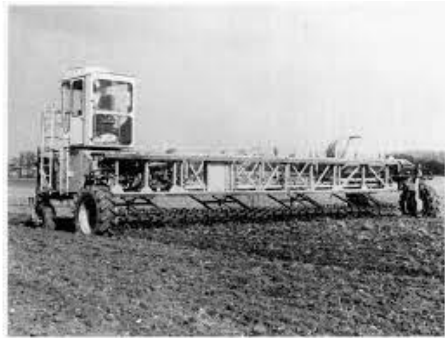
Рис.2.8 Британська мостова машина Silsoe Arable Gantry (SAG)
