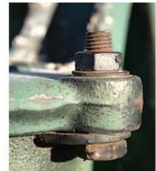
Стан болтових з'єднань
