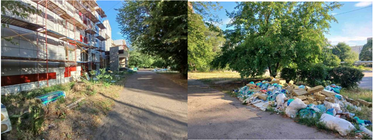
Рис. 2.3. Дніпровська гімназія № 143, ремонтні роботи
