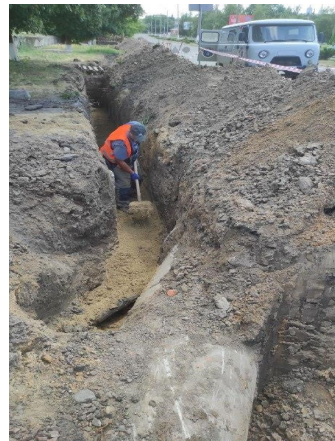
Рисунок 3.1 – Прокладання ділянки водопроводу
