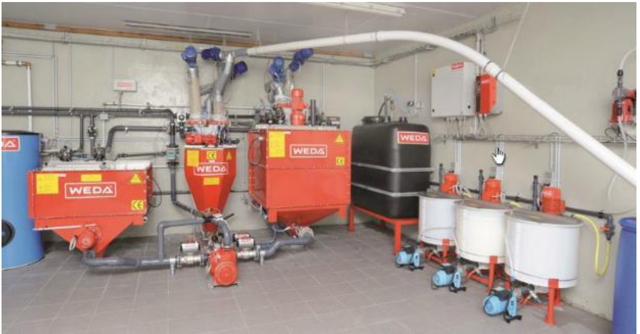
Рисунок 2.3 - Блок приготування кормосуміші системи Liquid Feeding System
