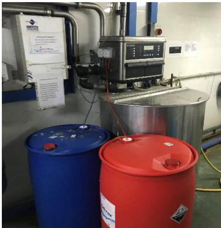
Рис. 12. Ємності з кислотою та лугом, що під'єднані до системи миття доїльного обладнання
