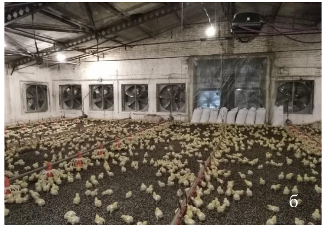
Рис. 13. Вентиляційні установки застосовані у пташниках відділення «Центральне» ТОВ «Птахокомплекс «Дніпровський»: а) вентиляційні шахти; б) торцеві вентилятори
