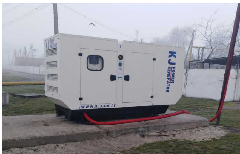
Рис. 14. Резервний генератор KJ POWER 5KJC
