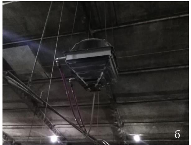
Рис. 12. Лінії опалення застосовані у пташниках відділення «Центральне» ТОВ «Птахокомплекс «Дніпровський»: а) теплогенератор Priva-90; б) франкоіл Proton Guard
