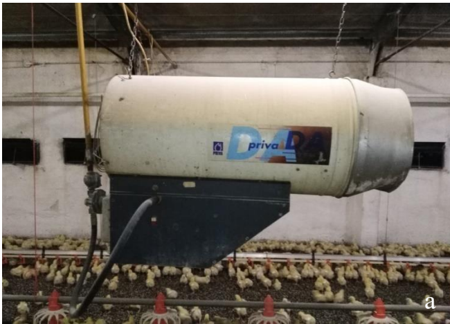
Рис. 12. Лінії опалення застосовані у пташниках відділення «Центральне» ТОВ «Птахокомплекс «Дніпровський»: а) теплогенератор Priva-90; б) франкоіл Proton Guard
