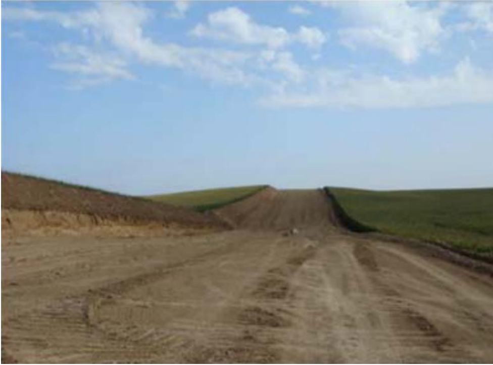
Рисунок 7.1 – Траса трубопроводу зі знятим рослинним ґрунтом
