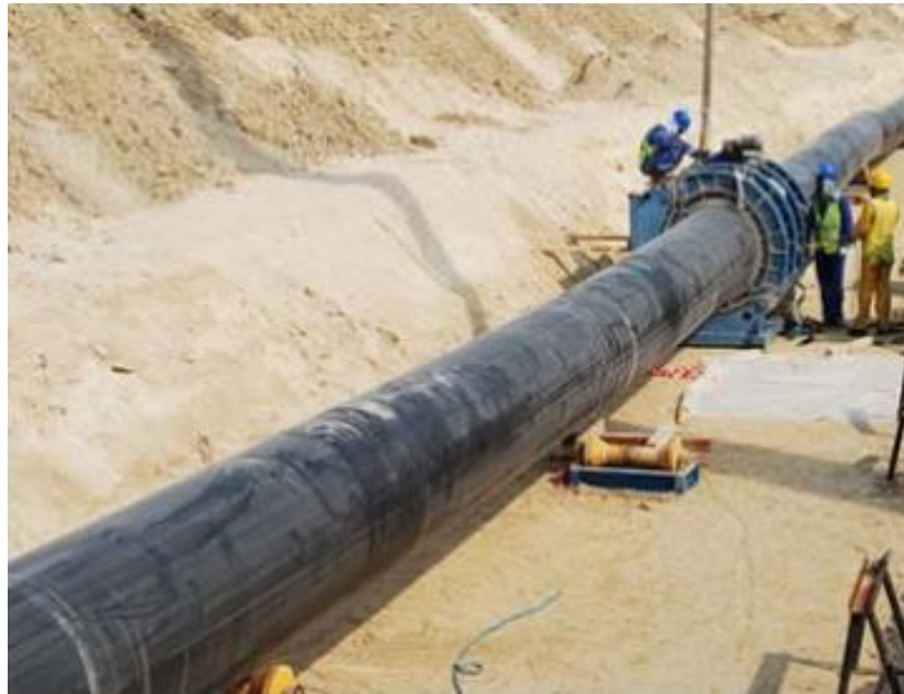
Рисунок 7.3 – Зварювання пластмасових труб великого діаметра
