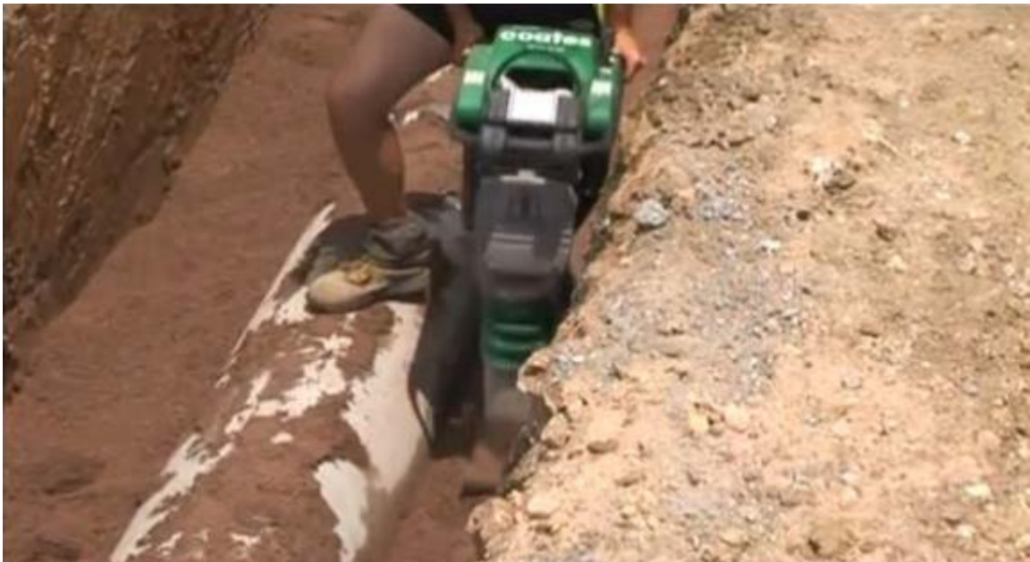
Рисунок 7.4 - Ущільнення ґрунту в затрубному просторі ручною електротрамбівкою
