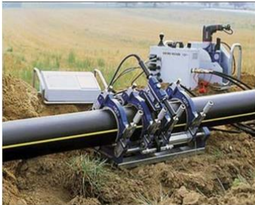
Рисунок 7.2 – Пристрій для зварювання пластмасових труб
